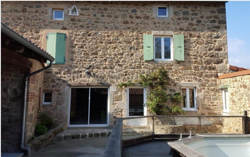
Crédit photo : La façade du gîte (Gîtes de France)
