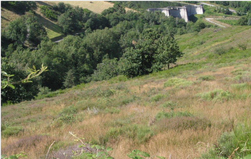
Barrage de Soulage (M jabrin Parc du Pilat)
