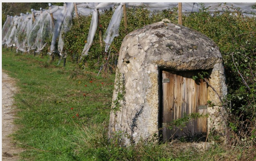
Puit du Bouillard
