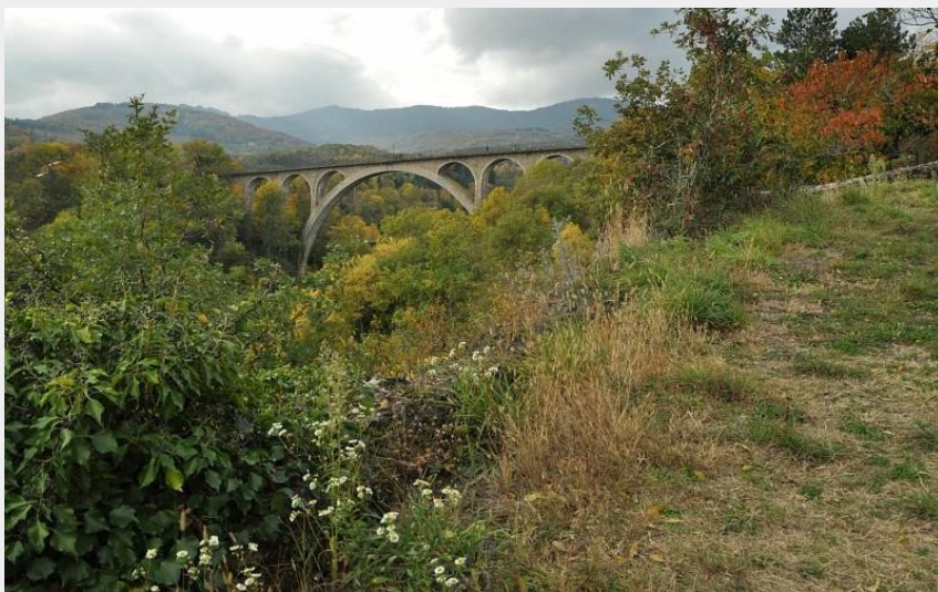
vue sur le viaduc (Mairie de Pélussin)
